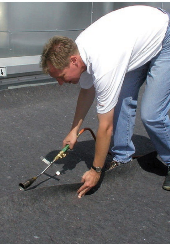
Der Überlappungsbereich kann mit Nahtbrenner verschweißt werden
